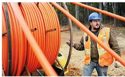
La posa di cavi di fibra ottica dove corrono le autostrade digitali
